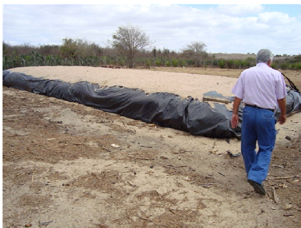
Silo I construído
